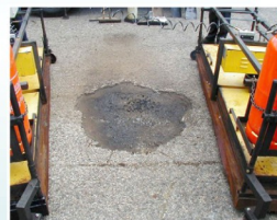
očistenie poškodeného miesta
